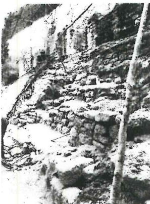
Edificio B-18, rasgos de la arquitectura encontrada antes de iniciar con los trabajos de restauración.
